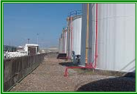
石化儲槽槽底、周邊
