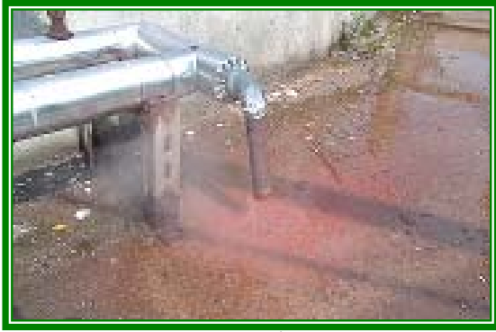
石化儲槽日常操作區
