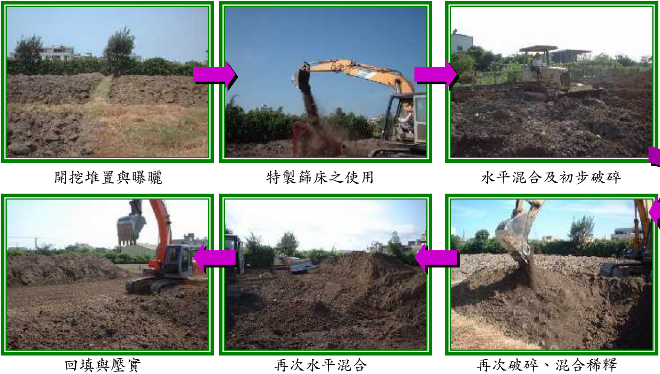
照片 4-9 土壤翻土混合稀釋法現場處理情形
