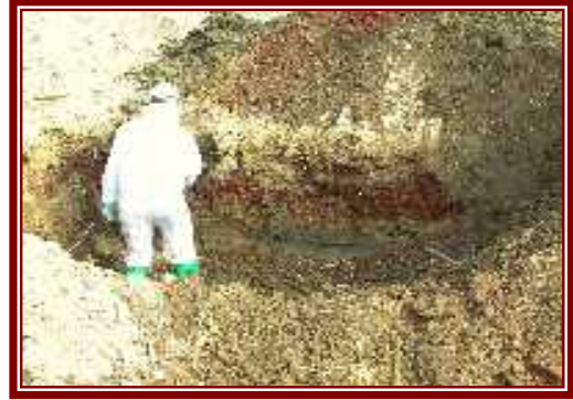
污染土壤開挖
