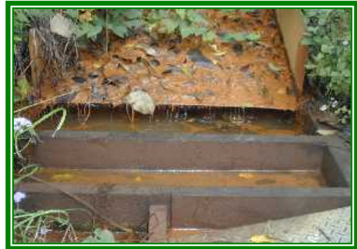
豎立告示牌禁止使用水
