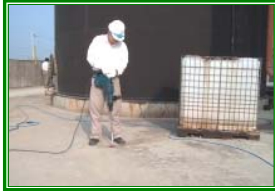
3. RC/PC破孔
